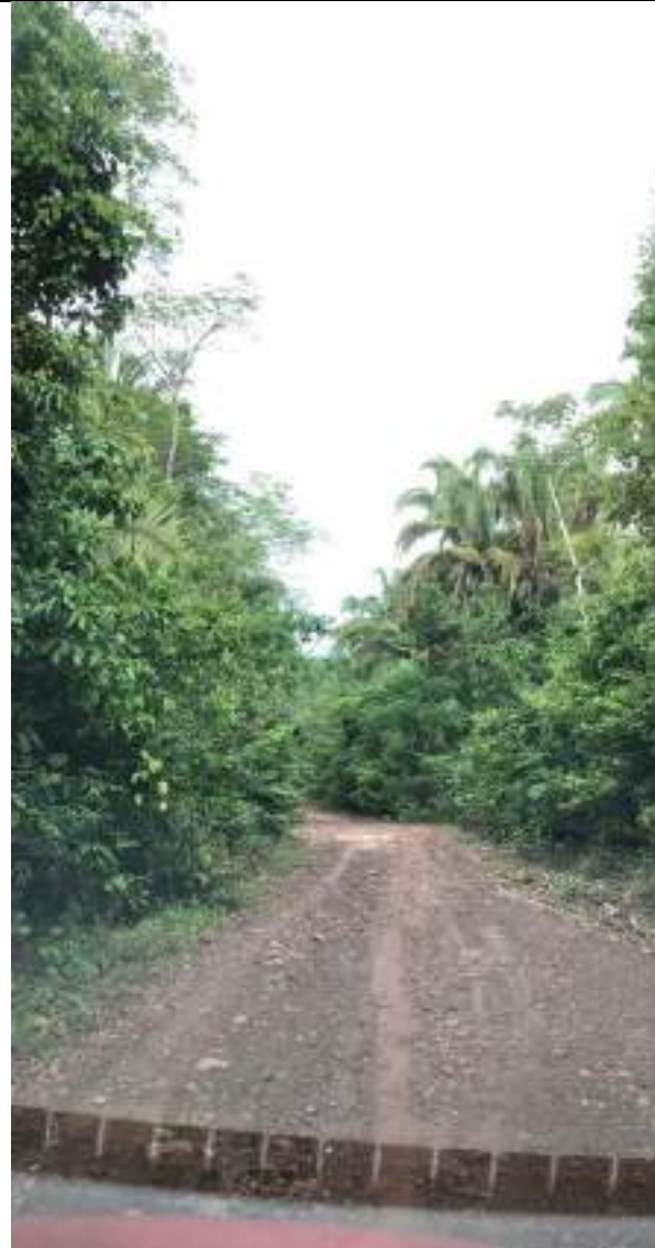
Fotografia 5 - Trecho entre Afonso Cunha e Pov. Vereda. Data 05/01/2022. - Latitude: -4.13851 - Longitude: -43.34470
