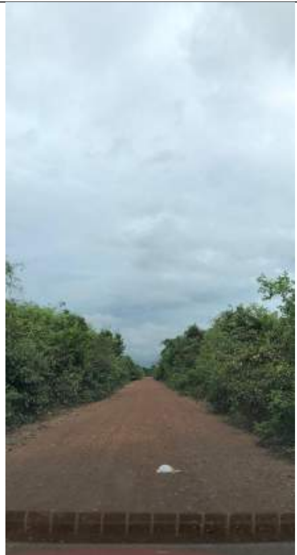
Fotografia 2 - início do Trecho - Data: 05/01/2022 - Latitude: -4.13954 - Longitude: -43.33400
