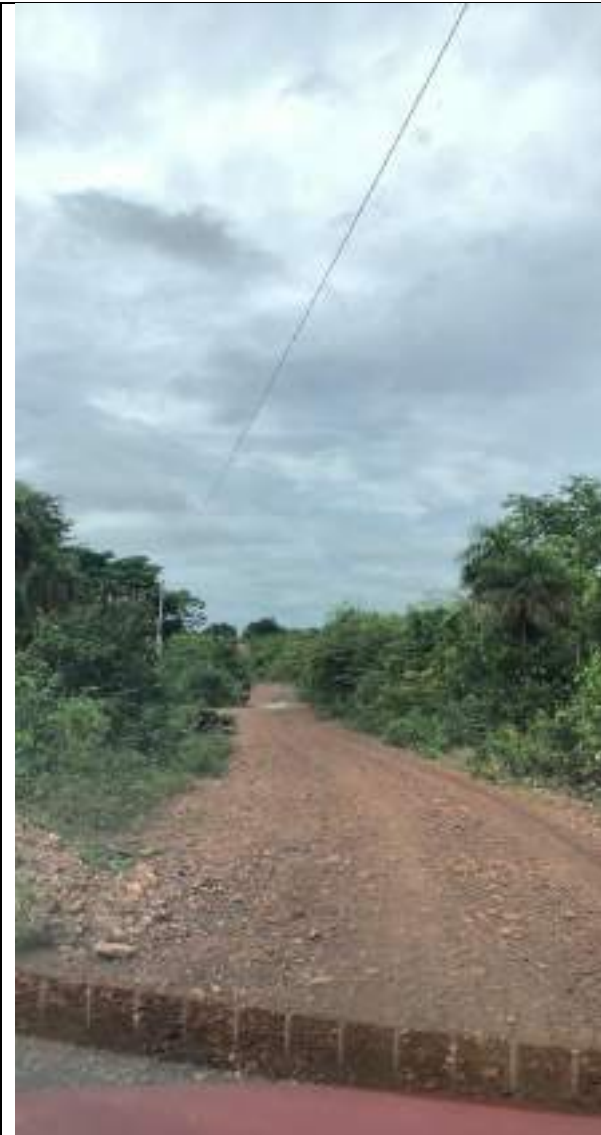
Fotografia 3 - Trecho entre Afonso Cunha e Pov. Vereda. Data 05/01/2022. - Latitude: -4.13782 - Longitude: -43.33689
